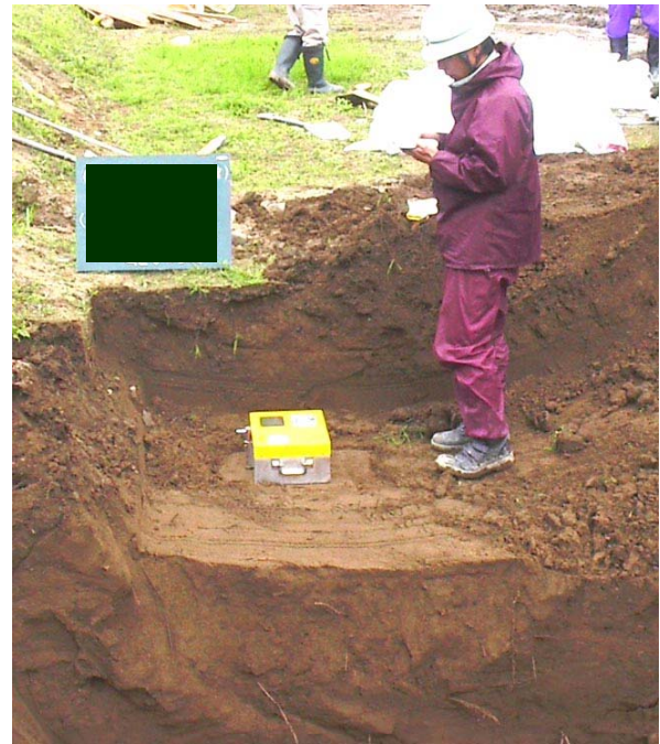
RI法による現場密度試験事例
