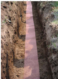
パワーメッシュの敷設
