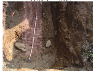
裸銅線の敷設
