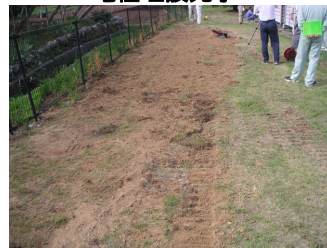
電極埋設完了
