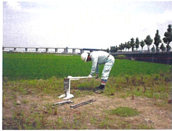
ロッド引き抜き
